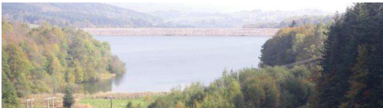
Vue du bassin où sont entreposés, sous eau, 1,3 Mt de résidus radioactifs. On distingue, au loin, la digue de retenue.
